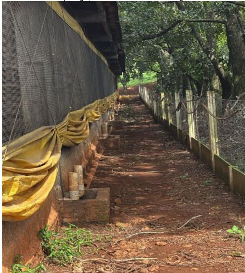
Figura 2. Área externa da pocilga, com estruturas de biosseguridade e conforto térmico.
